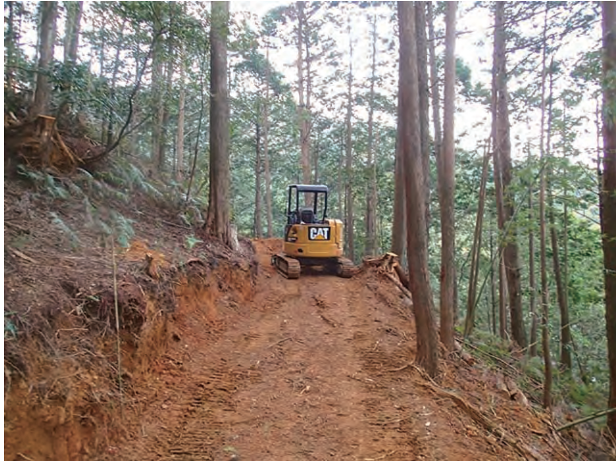
必要最小限の機械を使って適切な幅の作業道を開設
